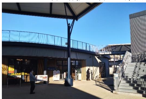
リビングテラスの屋上にあがれます
